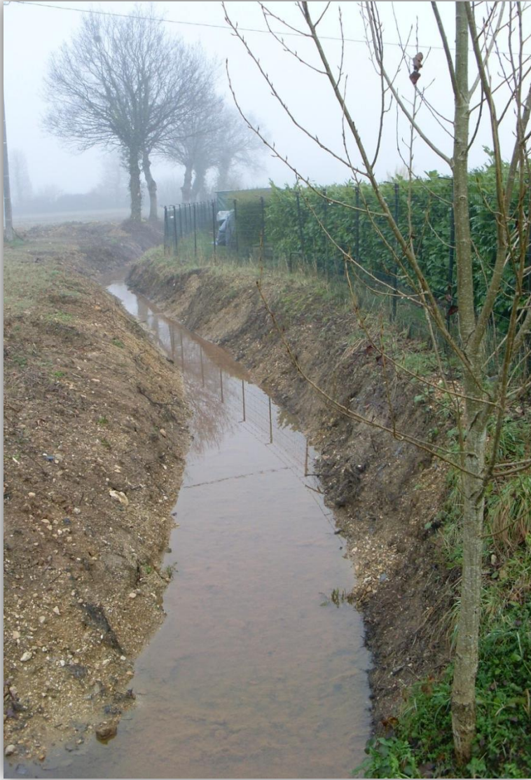
Photo 6 : la dégradation d'un cours d'eau de tête de bassin versant
