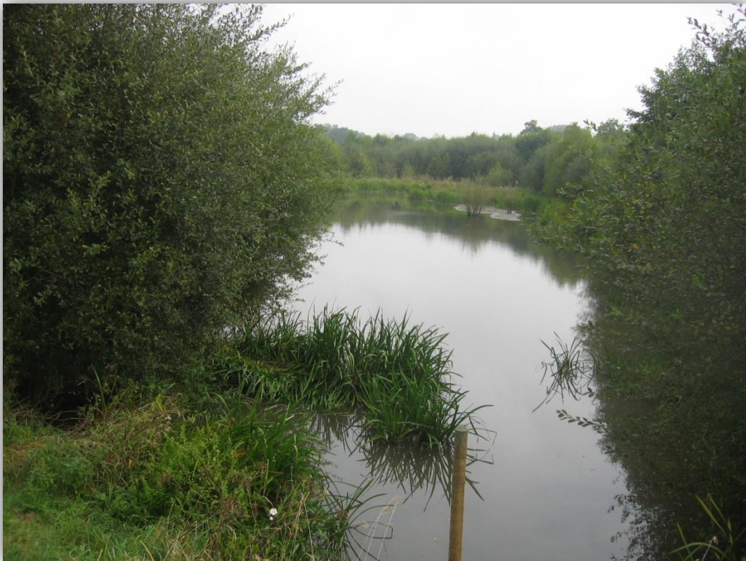
Photo 4 : aménagement de gestion des eaux pluviales localisé sur le ruisseau de Trémillé
