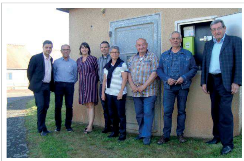
Les maires des communes d'Iffendic, Talensac, Montfort-sur-Meu, Pleumeleuc, Saint-Gonlay et Breteil coupent l'éclairage public.
